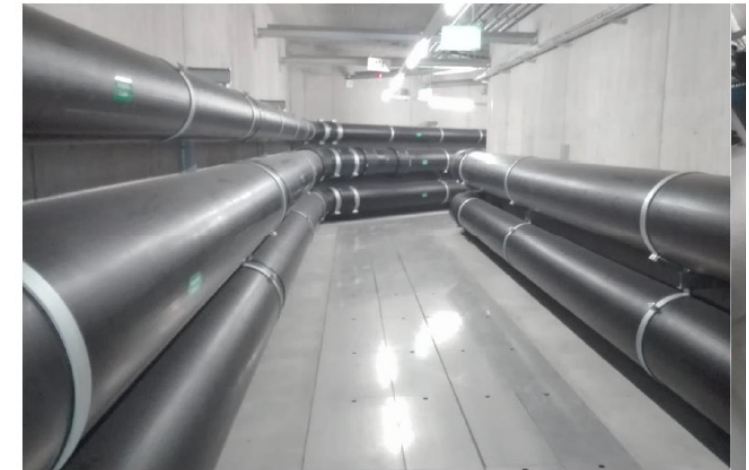
Slika 2. Horizontalni centralni razvod polja od 207 bušotina
