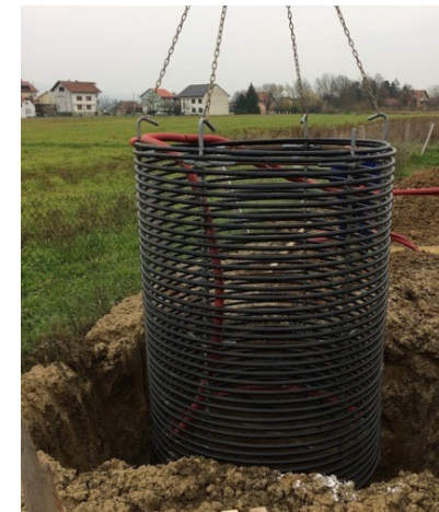
d) košarasta izvedba izmjenjivača
