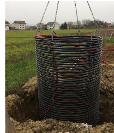
d) košarasta izvedba izmjenjivača
