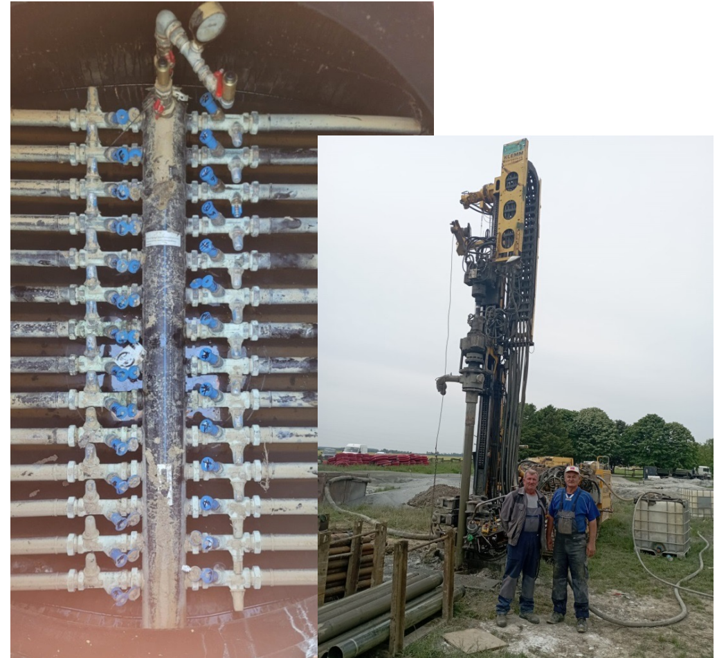
Sabirnik polja s 28 bušotinskih izmjenjivača topline
